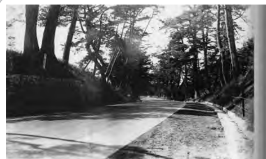
舗装工事完了後の東海道(現赤松町付近) 出典：茅ヶ崎 きのうきょう (写真集)
